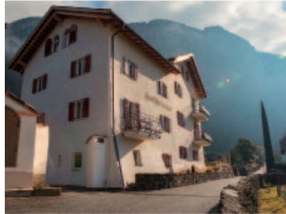
Altes Haus auf dem neuesten Stand: Bei der Restaurierung vom Hochbrunner Hof wurden die dicken Außenmauern mit Steinwolle isoliert
